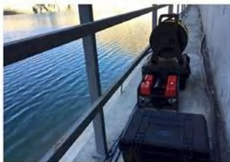
大坝检查: 甘肃某水库大坝进行检测
