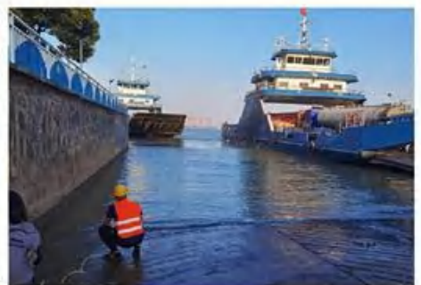
水利检测: 某渡口水下壁面进行检查
